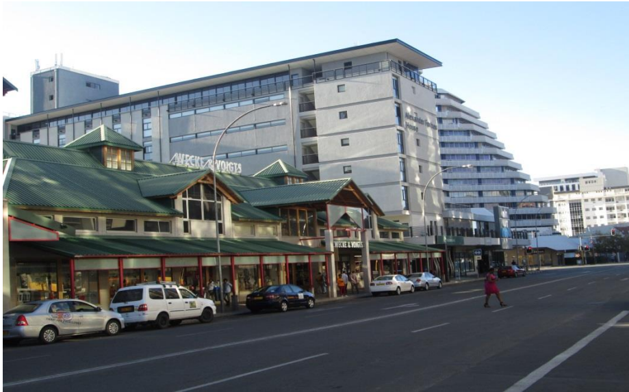
Photo 22: Gustav Voigts Centre
