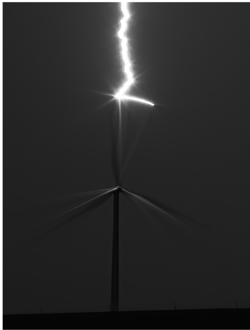
Figura 9: Raio ascendente iniciado em uma pá de uma turbina eólica. Durante a ocorrência da CCI o movimento giratório da pá arrasta o canal do raio consigo. Fonte: Tom A. Warner.
