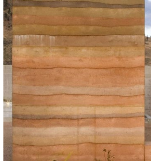
Fig 8.12 "Rammed earth wall"
