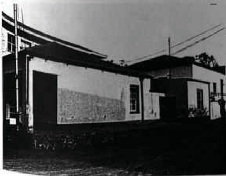
300. Erf 290: ? Bell Street.
