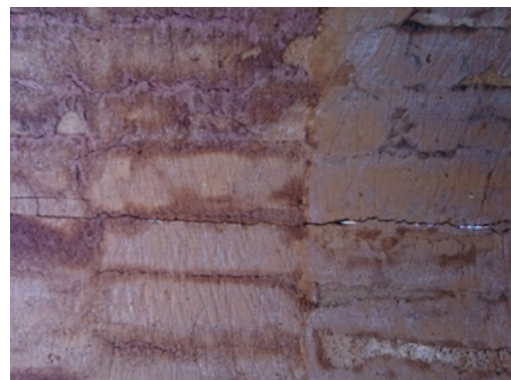
(d) Apex crack (internal)
