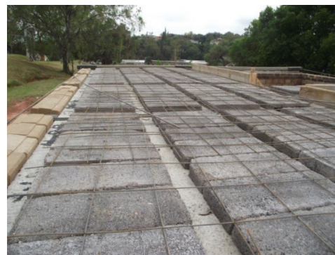
(d) Rib and block slab
