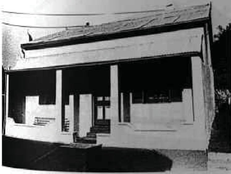
287. Erf 285: 11 Bell Street.
