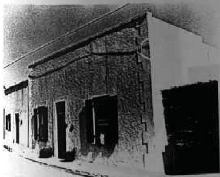
Erf 308: 28 Bell Street.
