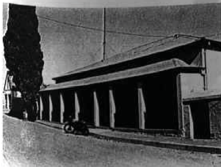
9. Erf 333: 4 Bell Street.
