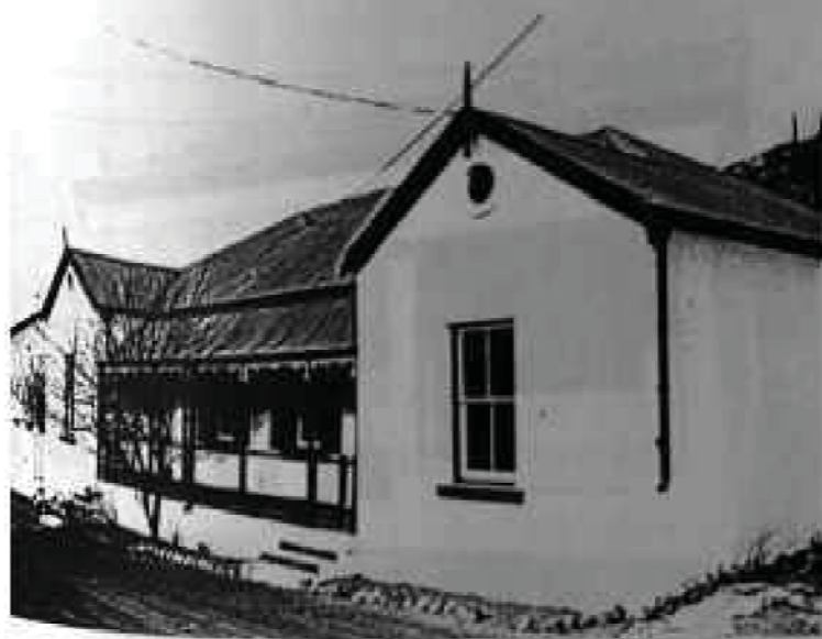
195. Erf 297: 15 Bell Street.
