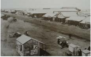
Tin shed (van der Waal 1987: 12)
