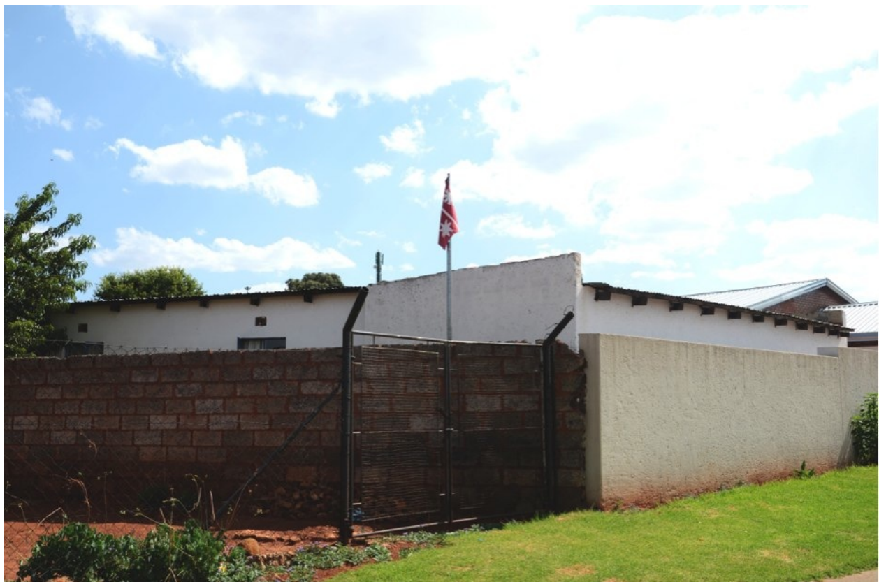
Figure7 & 8: Madutlo Street, Naledi.
