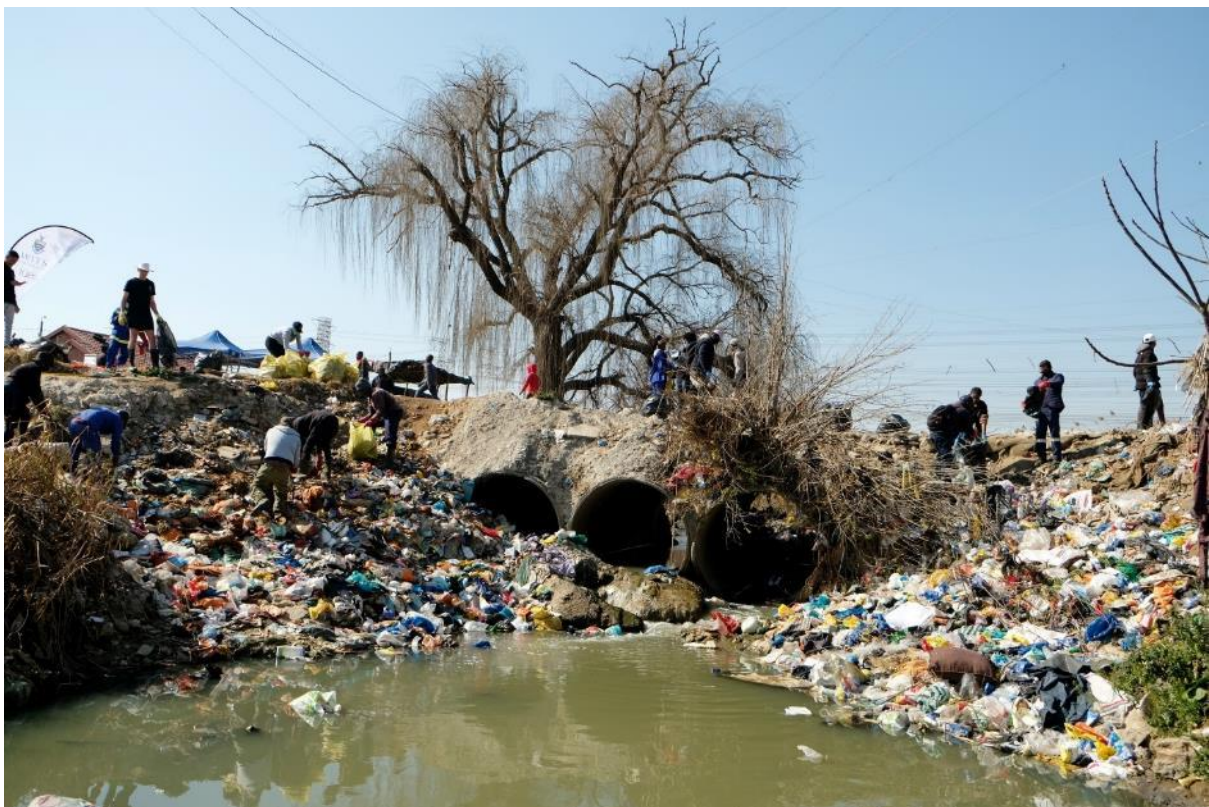
eSiphetweni-Vusimuzi Bridge in Tembisa.
